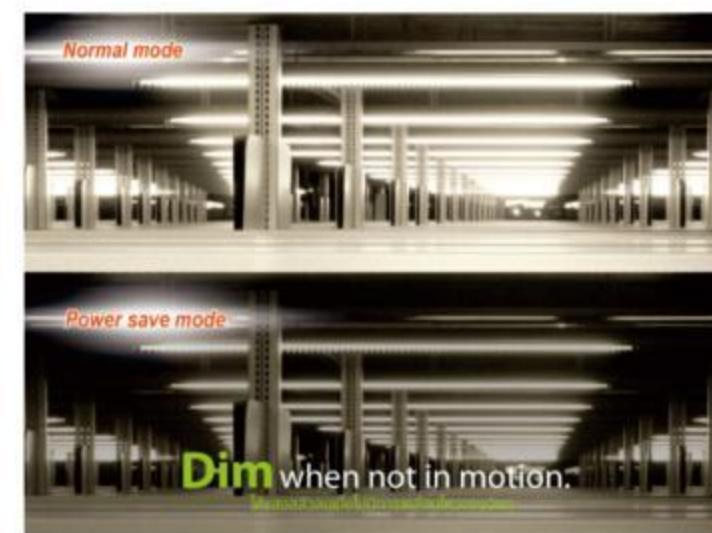
例如，在一個停車區域中有500盞燈，分為10個Master ID1-10，每個區域的Master都控制著49個從屬管的不同組。當主機檢測到運動時，屬於同一主機組的主機和從機應點亮。當主機未檢測到運動時，根據延遲時間的預設配置，相同的組照明將變暗或熄滅。可以通過主管上的撥碼開關或通過從製造商的網站下載的移動應用軟件來設置管的預設配置，還可以進行區域間協作控制。
